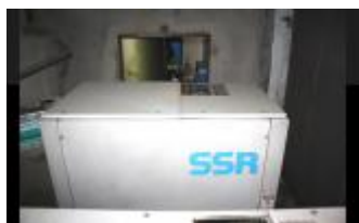
Referencia: EST-43 Compresor Año: . Marca: Ingersollrand Ancho mesa: .
